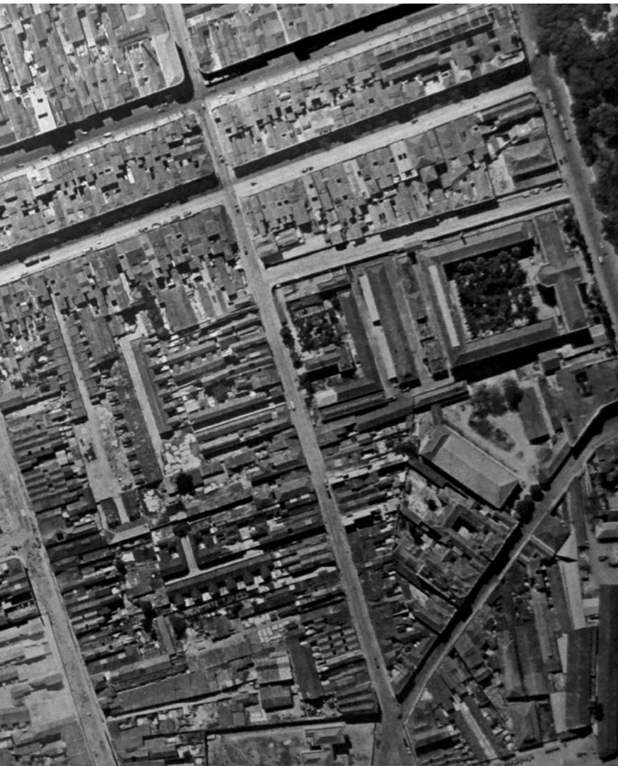
Figura 02 - A Estrutura urbana da área central antes da abertura da Avenida Presidente Vargas registrada no Mosaico Fotográfico de 1928/1935. Neste trecho vê-se a Avenida do Mangue entre a Fábrica de Gás e o Campo de Santana. As quadras situadas entre este Campo e a Praça XI, próxima ao Canal do Mangue, seriam demolidas para abertura do prolongamento dessa avenida em direção ao Cais dos Mineiros. Fonte: AGCRJ, Avenida Presidente Vargas – Prefeitura do Distrito Federal, Diretoria de Secretaria do Gabinete (sem autor), 1935.
